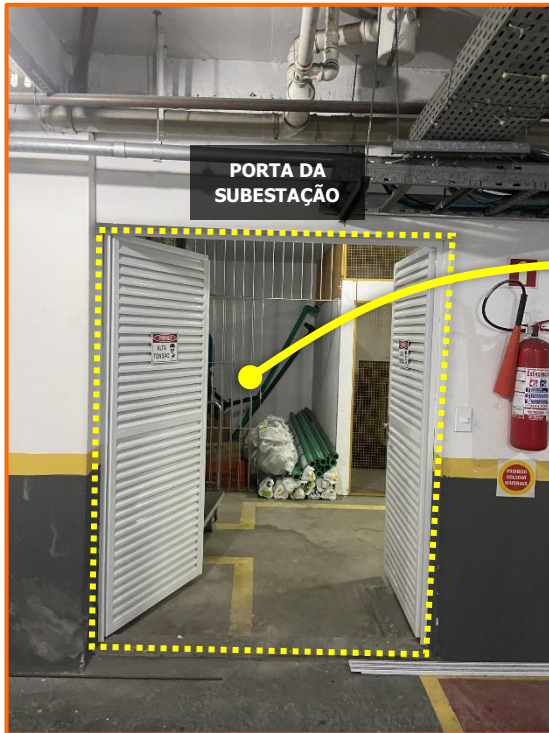
32 – Acúmulo de material dentro da subestação.
