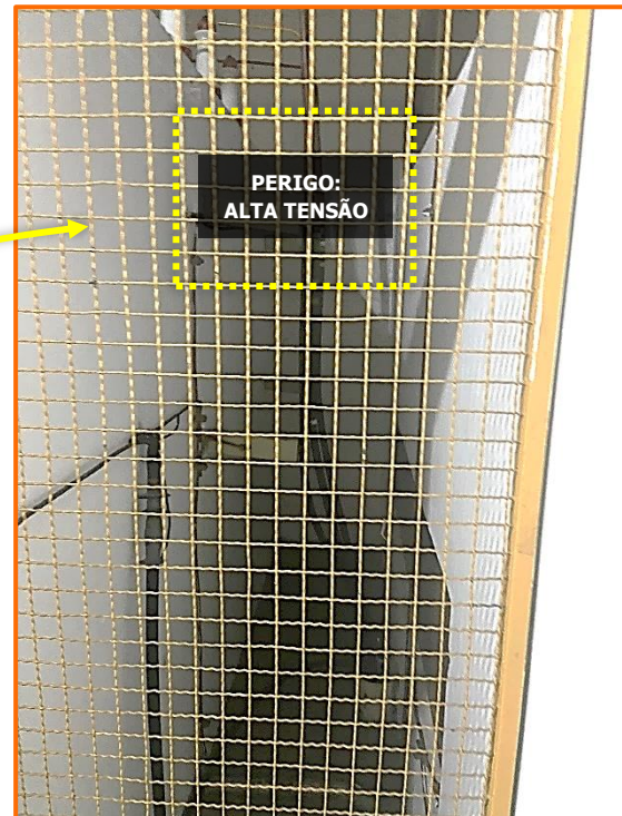
3 – Grade do cubículo do ramal de entrada sem placa de advertência.
