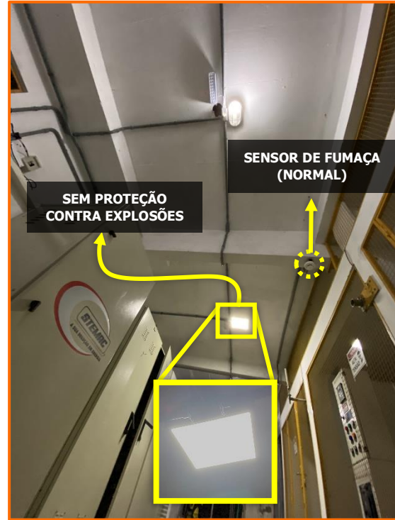
29 – Visão geral do teto da subestação.
